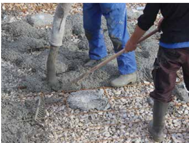
Coulage fond plat
