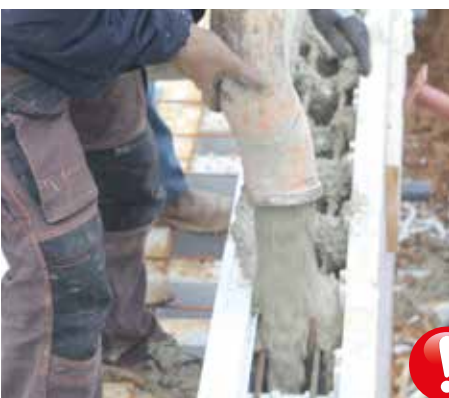
Attention à amorcer la pompe en dehors de la structure
