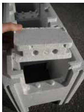
Bouchon haut avant mise en place
