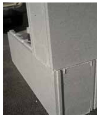
Détail d'angle avec bouchons assemblés
