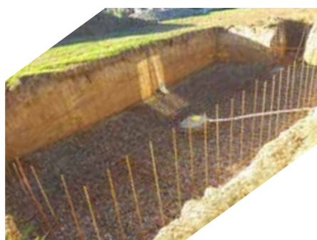
Treillis avec attentes verticales
