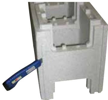
Découpe au cutter de la languette mâle du bloc qui sera en butée dans l'angle
